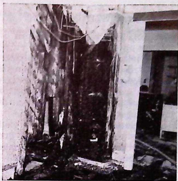
Bild 4. Interiör från lägenheten i fjärde våningen, där släckningsangreppet först insattes. Trätrumman på bilden kommer från den lägenhet, där branden började och spred branden till vinden.
